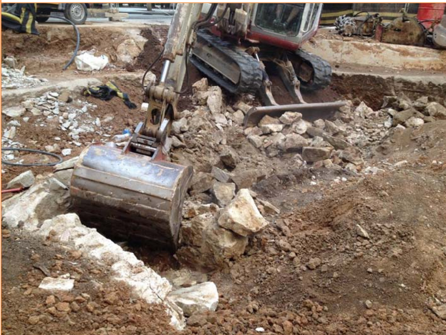
Foto 30. Treballs d'enderroc de les estructures UE 3, UE 5 i UE 10.
