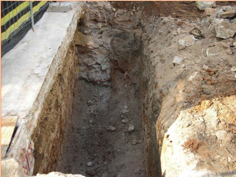
Foto 6. Estat final de la rasa sud.
