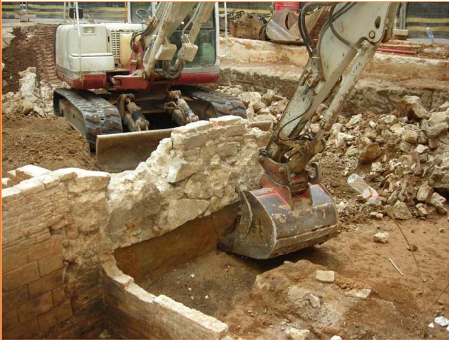
Foto 31. Treballs d'enderroc de les estructures UE 18, UE 20, UE 27 i UE 34.
