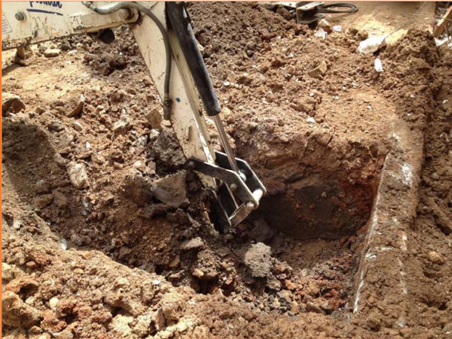
Foto 7. Treballs d'obertura de la cala 7..
