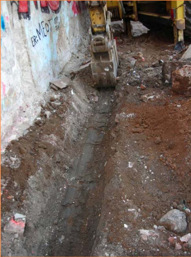
Foto 5. Treballs d'obertura de la rasa oest.
