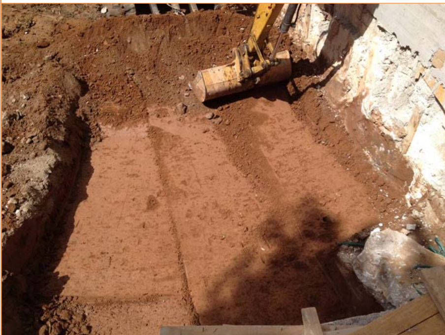
Foto 32. Treballs d'extracció de terres fins a cota final d'obra.
